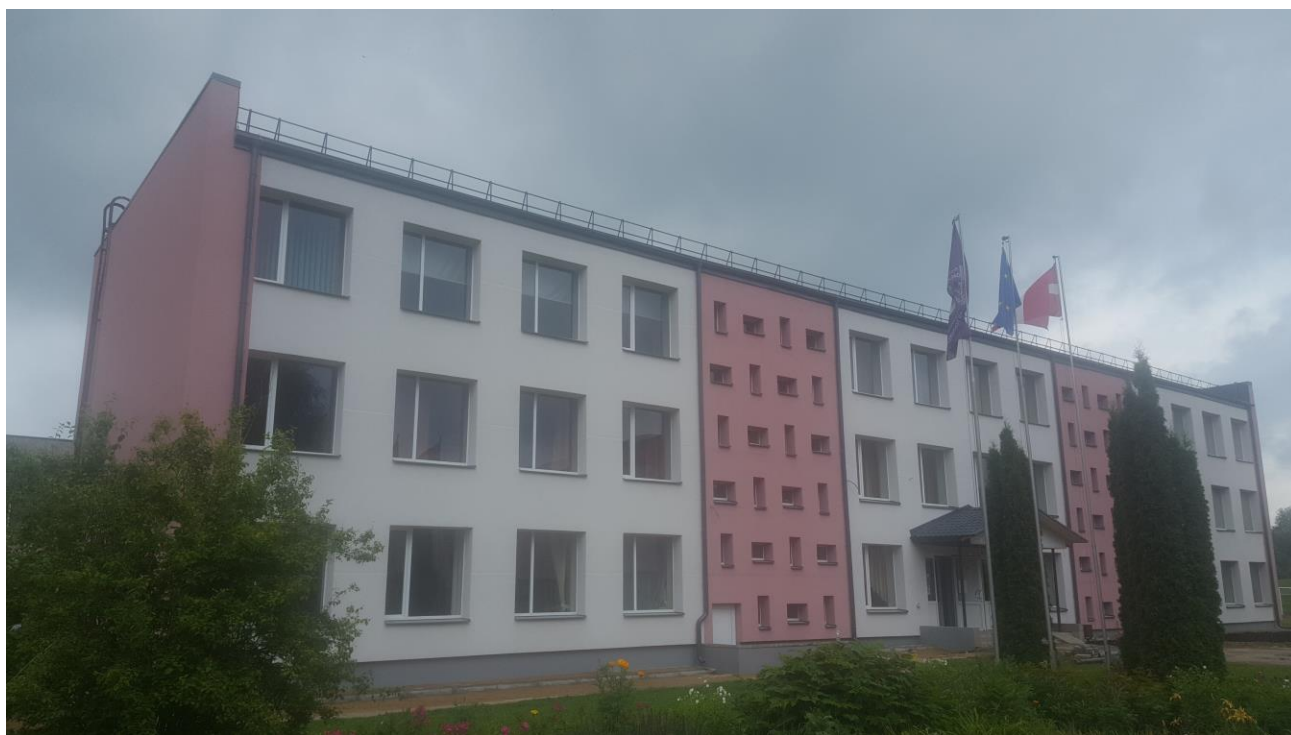
Daugavpils Būvniecības tehnikuma IPĪV “Dagda” nosiltinātā administratīvā ēka – mācību korpus (adrese: Brīvības iela 3, Dagda).
